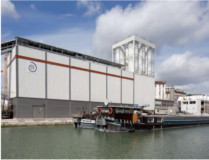
Unité de production Unibéton d'Aubervilliers (93).
