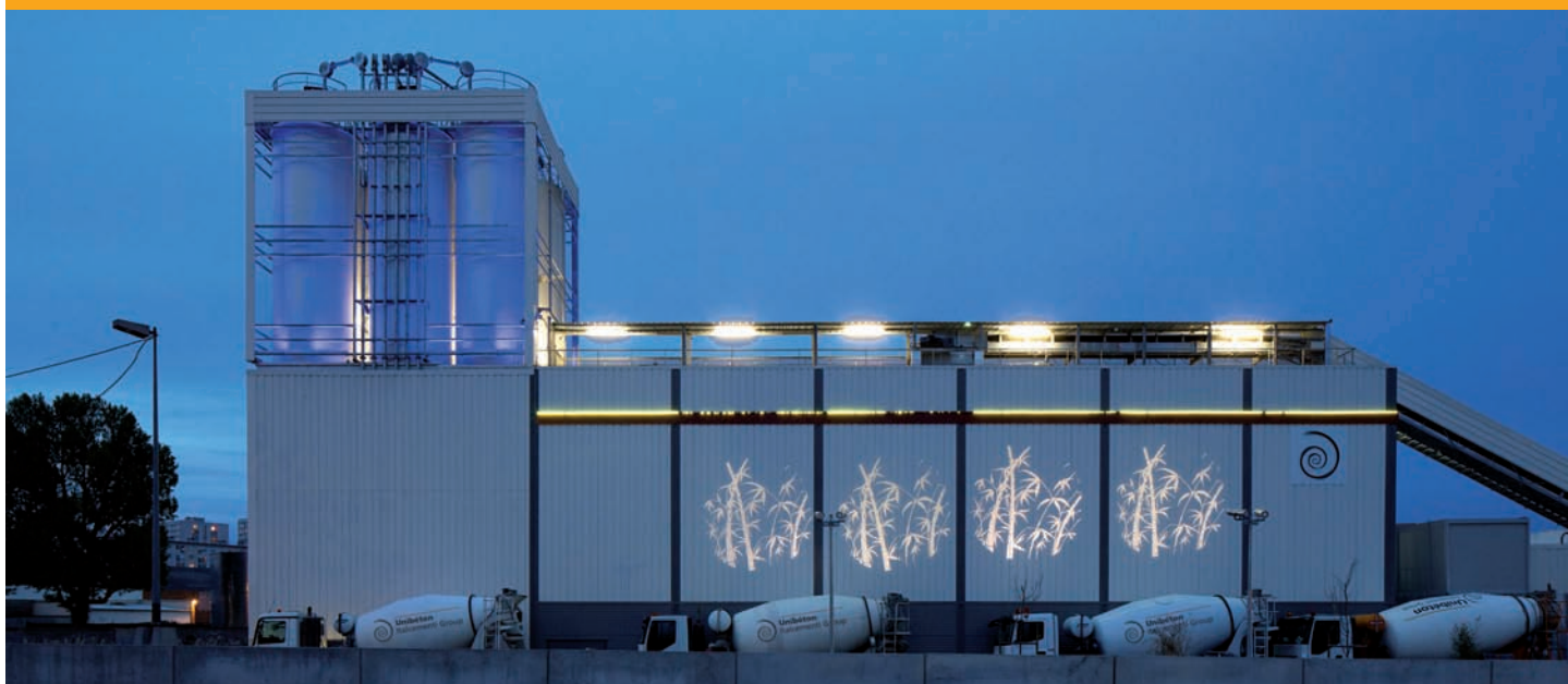
Unité de production Unibéton d'Aubervilliers (93), prix de la catégorie Recherche architecturale (concours photographique 2014 du SNBPE).
