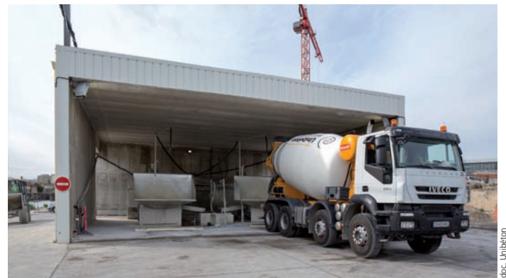
Station de recyclage de l'unité de production Unibéton d'Aubervilliers (prix de la catégorie Recyclage du concours photographique 2014 du SNBPE).
